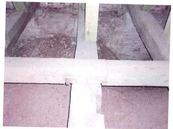
fot. nr 10 ŁĄCZENIE BELEK PODWALINOWYCH
