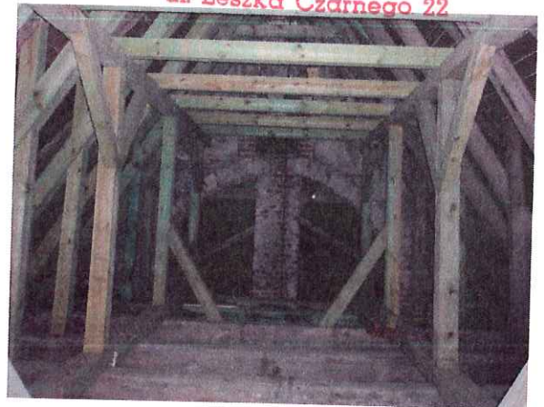
fot. nr 8 WIDOK WIĄZARA PŁATWIOWO-KROKWIOWEGO
