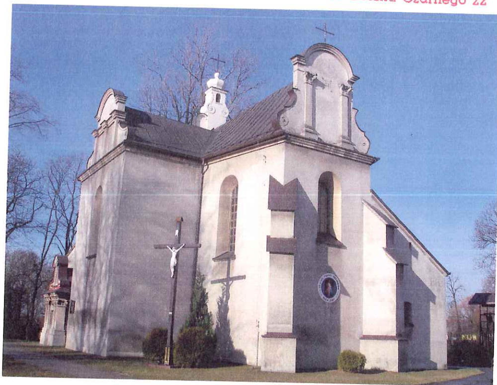
fot. nr 1 WIDOK ELEWACJI POŁUDNIOWO-WSCHODNIEJ
