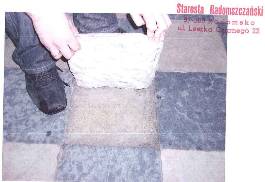
fot. nr 5 POSADZKA KOŚCIOŁA
