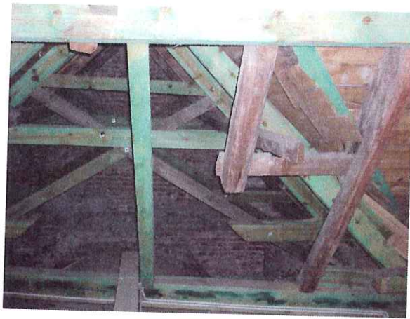
fot. nr 7 KONSTRUKCJA DACHU
